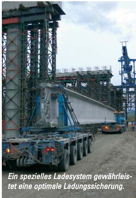
*Ein spezielles Ladesystem gewährleistet eine optimale Ladungssicherung.*
