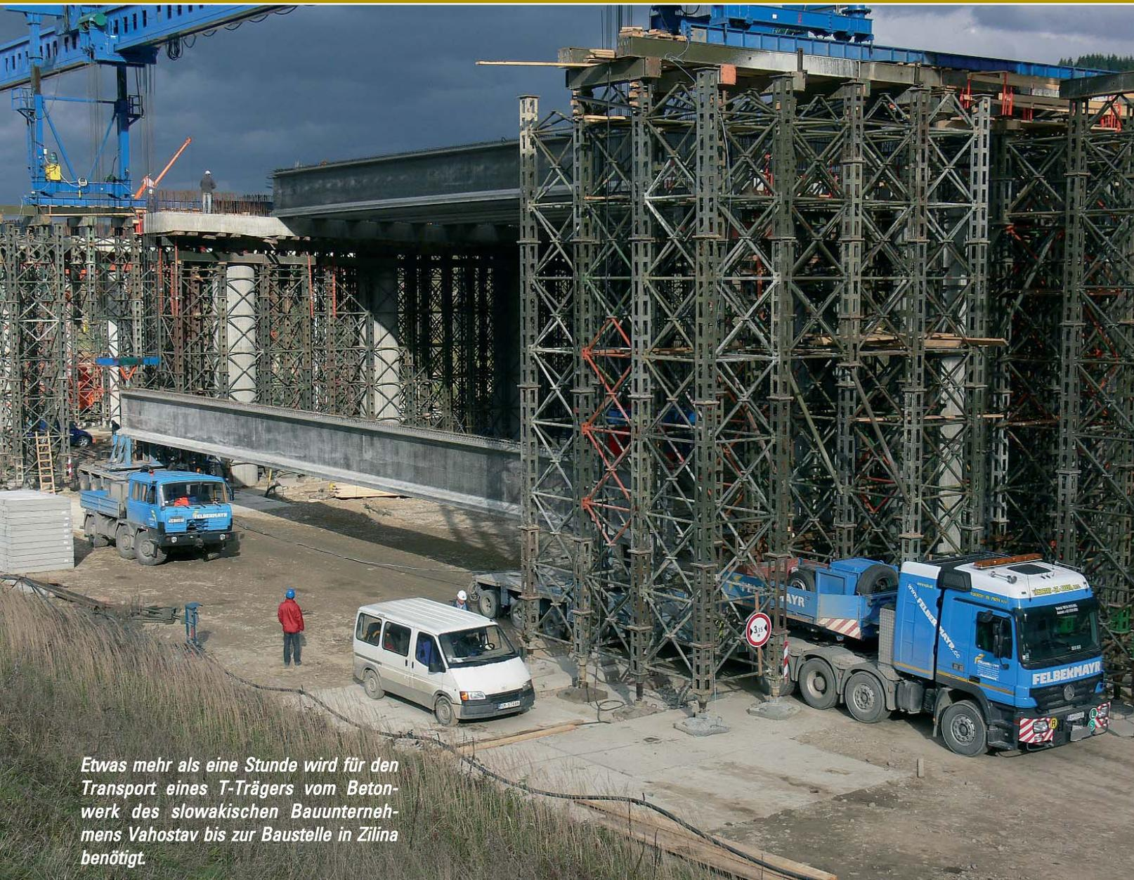
*Etwas mehr als eine Stunde wird für den Transport eines T-Trägers vom Betonwerk des slowakischen Bauunternehmens Vahostav bis zur Baustelle in Zilina benötigt.*
