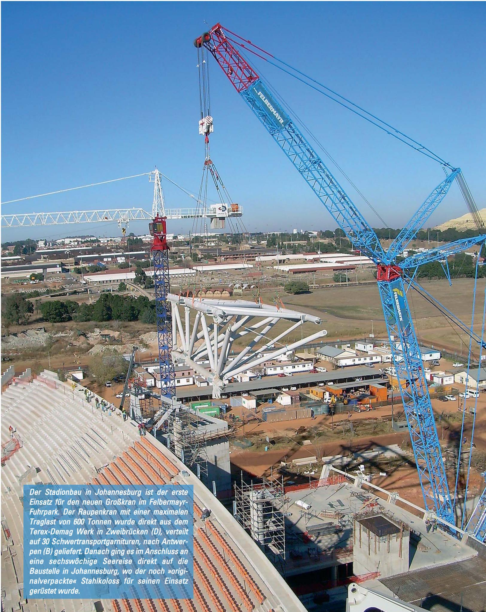
*Der Stadionbau in Johannesburg ist der erste Einsatz für den neuen Großkran im Felbermayr-Fuhrpark. Der Raupenkran mit einer maximalen Traglast von 600 Tonnen wurde direkt aus dem Terex-Demag Werk in Zweibrücken (D), verteilt auf 30 Schwertransportgarnituren, nach Antwerpen (B) geliefert. Danach ging es im Anschluss an eine sechswöchige Seereise direkt auf die Baustelle in Johannesburg, wo der noch »originalverpackte« Stahlkoloss für seinen Einsatz gerüstet wurde.*
