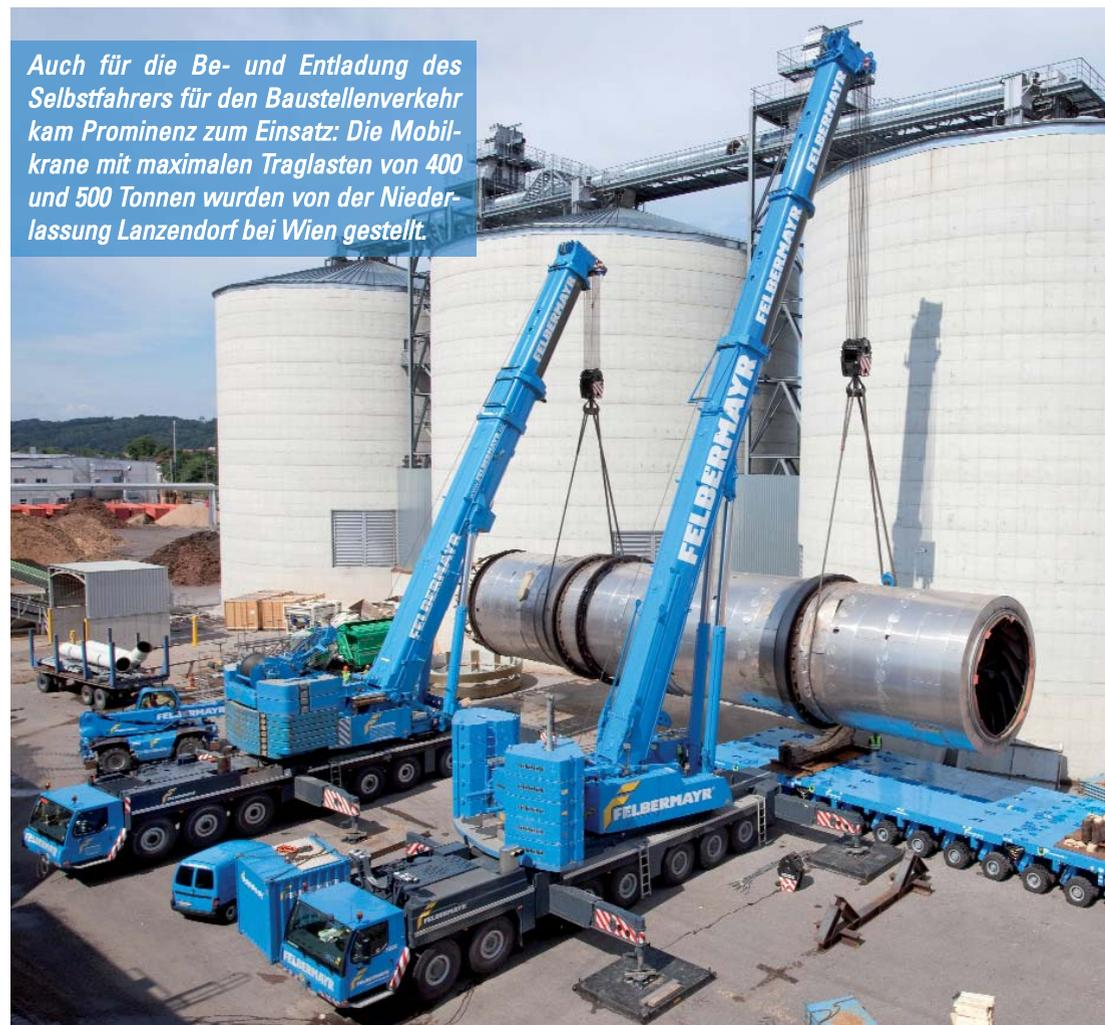
*Auch für die Be- und Entladung des Selbstfahrers für den Baustellenverkehr kam Prominenz zum Einsatz: Die Mobilkrane mit maximalen Traglasten von 400 und 500 Tonnen wurden von der Niederlassung Lanzendorf bei Wien gestellt.*
