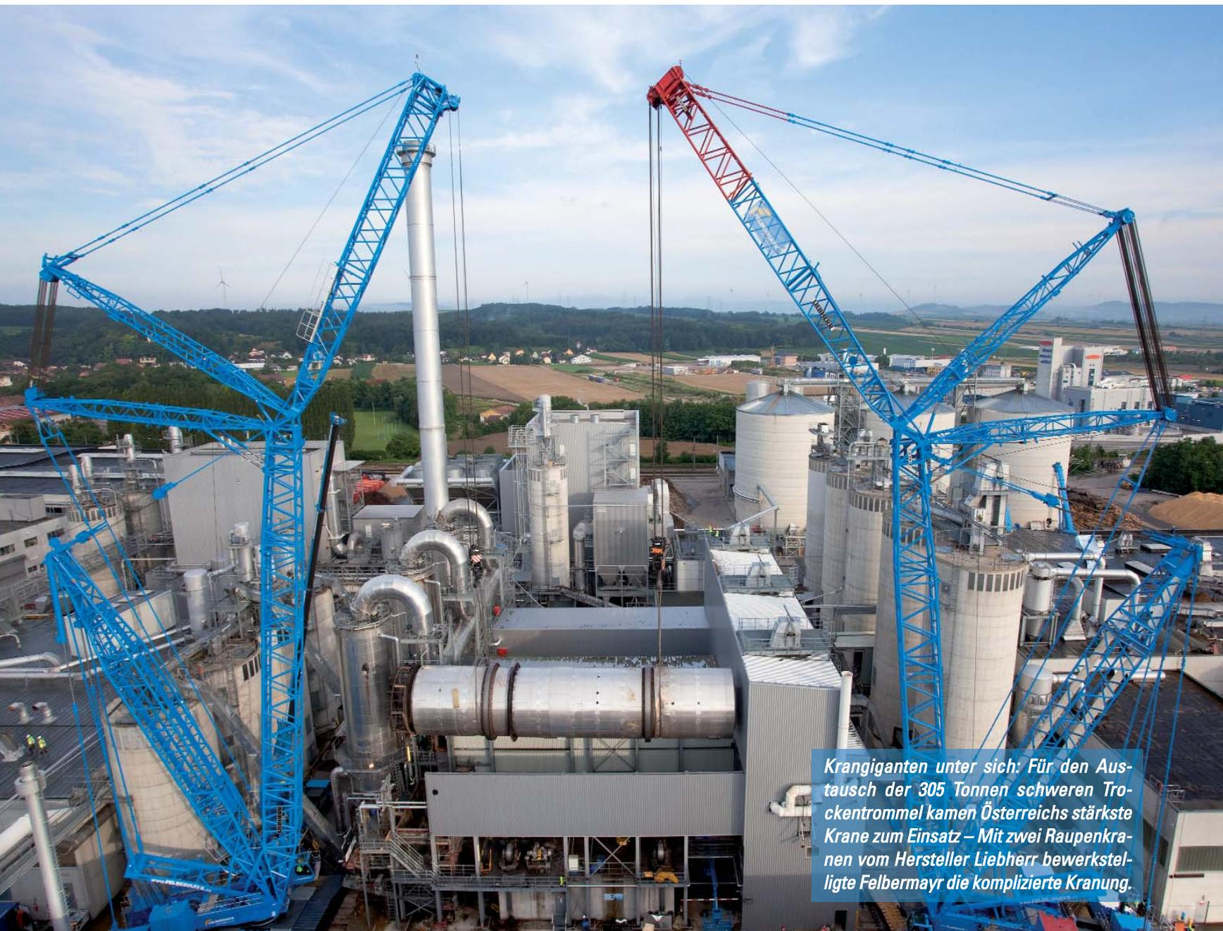
*Krangiganten unter sich: Für den Austausch der 305 Tonnen schweren Trockentrommel kamen Österreichs stärkste Krane zum Einsatz – Mit zwei Raupenkränen vom Hersteller Liebherr bewerkstelligte Felbermayr die komplizierte Kranung.*
