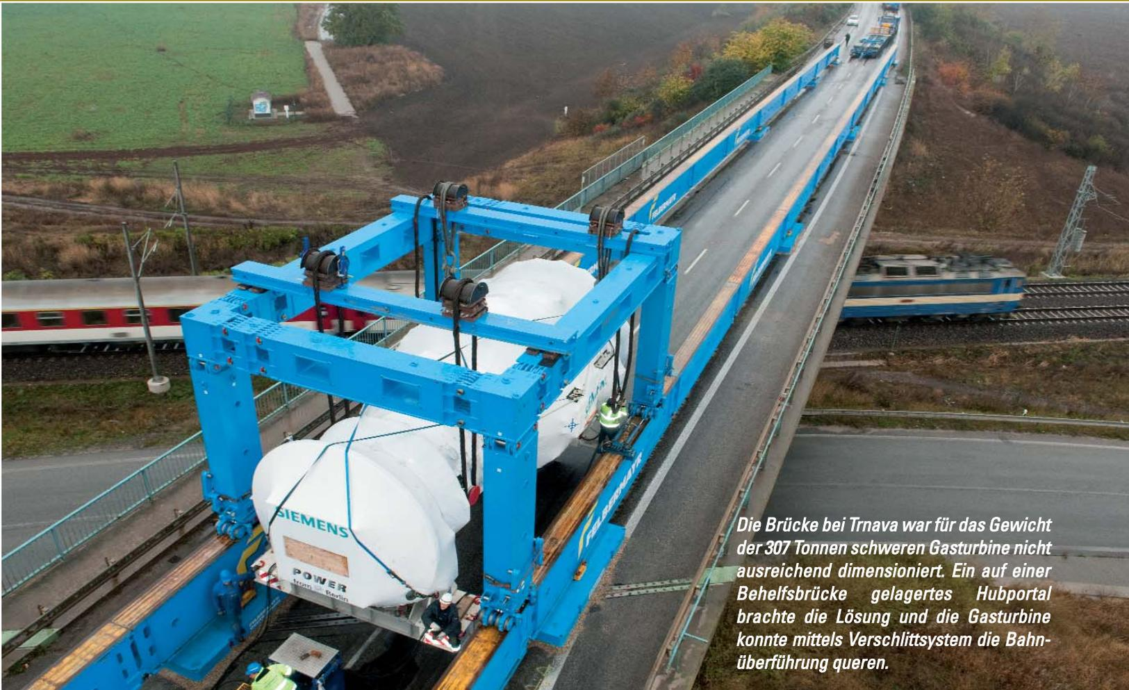
*Die Brücke bei Trnava war für das Gewicht der 307 Tonnen schweren Gasturbine nicht ausreichend dimensioniert. Ein auf einer Behelfsbrücke gelagertes Hubportal brachte die Lösung und die Gasturbine konnte mittels Verschlittsystem die Bahnüberführung queren.*
