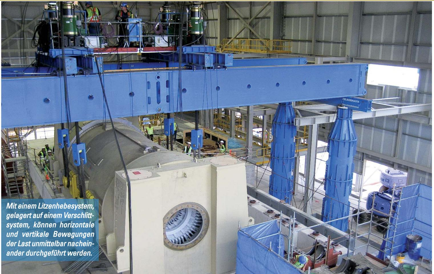
Mit einem Litzenhebesystem, gelagert auf einem Verschleißsystem, können horizontale und vertikale Bewegungen der Last unmittelbar nacheinander durchgeführt werden.
