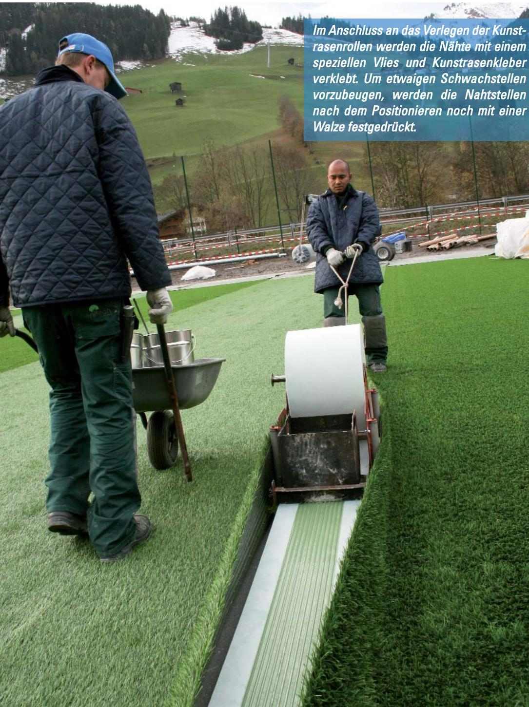
**Präzisionsarbeit:** Der aus vier Meter breiten Bahnen bestehende Kunstrasen wird mit einem Spezialfahrzeug über den Platz bewegt und von Hand verlegt.
