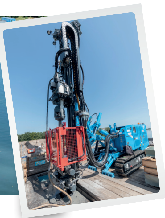
Cu ajutorul unui ponton și al unui aparat de foraj, au fost extrase carote de 20 de metri din albia râului.
